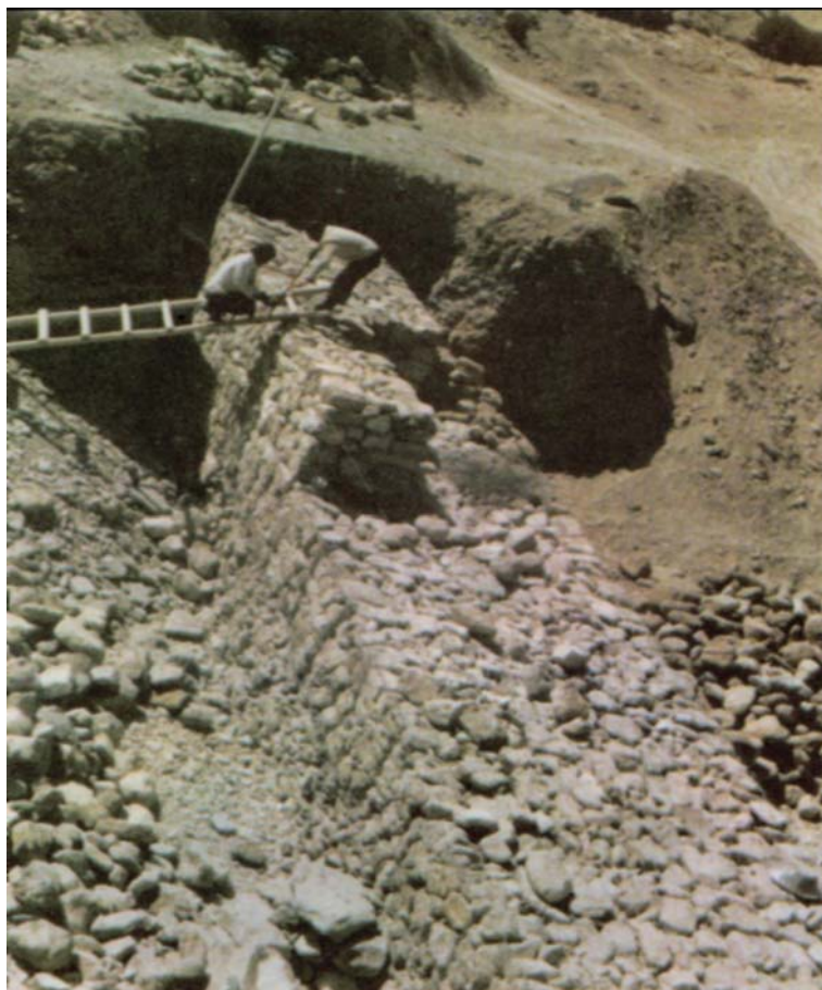
تصویر (۲۲-۲): سرریز توریسنگی در حال ساخت
