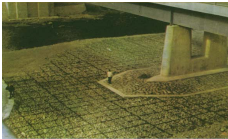
تصویر (۱۵-۲): کف بند توریسنگی در اطراف پایه پل
