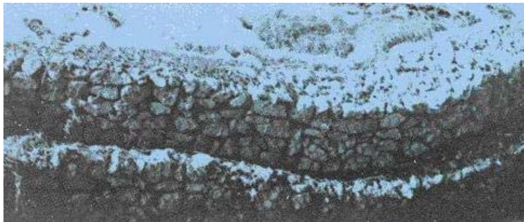
شکل (۸-۱): انعطاف پذیری توریسنگ در مقابل نشست های قائم
