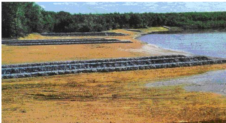
شکل (۱۰-۱): رودخانه ای قبل و بعد از اجرای اپی
