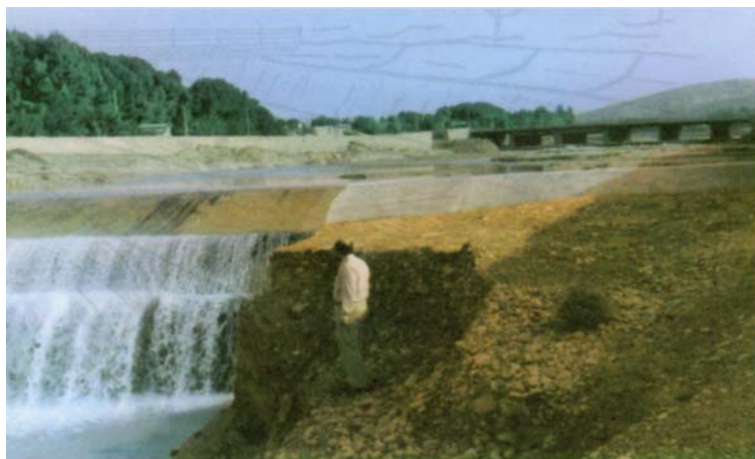
تصویر (۱۷-۲): کاهش آبشستگی با کاهش شیب و اجرای آبنا در پایین دست پلیدر شیراز
