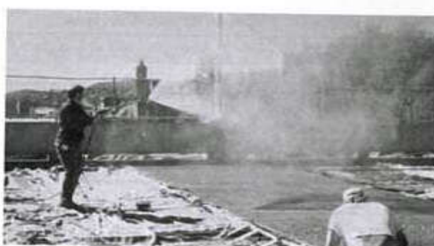
شکل ۴.۸ الف مه پاشی مناسب بتن میکروسیلیسی در سازه پارکینگ برای افزایش رطوبت و جلوگیری از خشک شدن سطح بتن.
