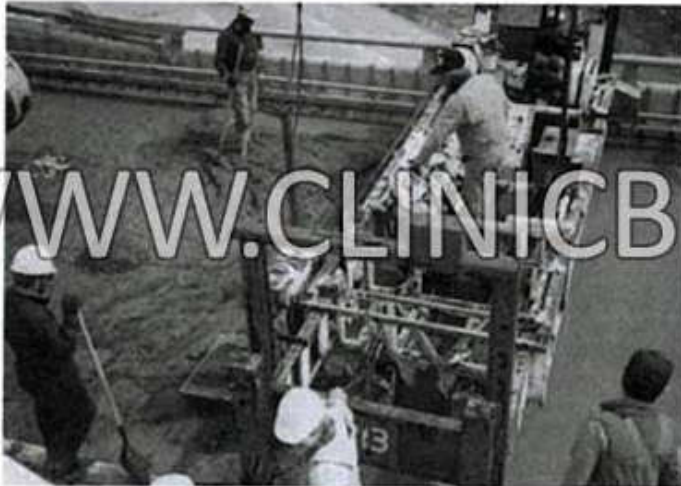
شکل ۹.۸ ماشین ساخت عرشه پل مورد استفاده برای روکش بتنی میکروسیلیسی.
