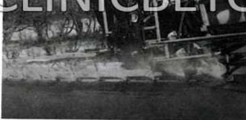
شکل ۴.۸ ب تجهیزات مه پاشی بسته شده روی ماشین ساخت روسازی. توجه کنید که نازل های مه پاشی رو به بالا هستند، به گونه ای که رطوبت به سطح بتن اضافه نمی شود.
