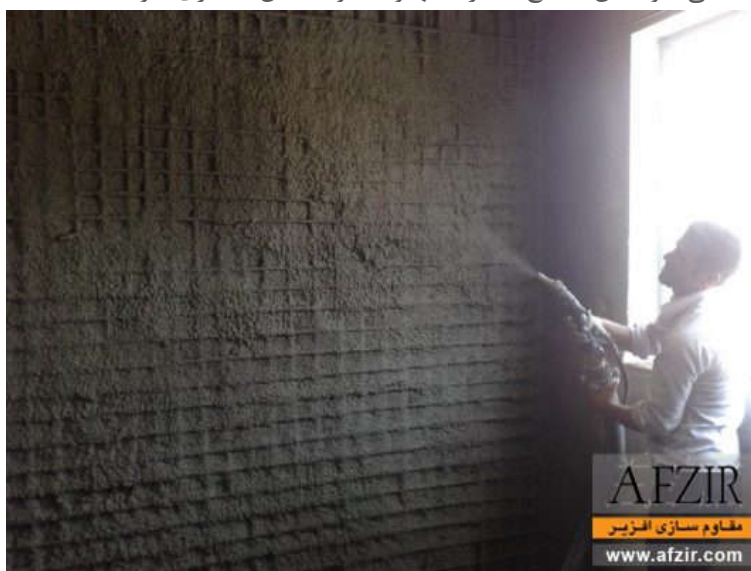
اجرای شاتکریت در دیوار بتنی
