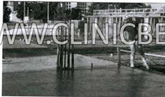
شکل ۵.۸ به کارگیری کندکننده تبخیر روی بتن میکروسیلیسی برای جلوگیری از افت رطوبت قبل از شروع عمل آوری.
