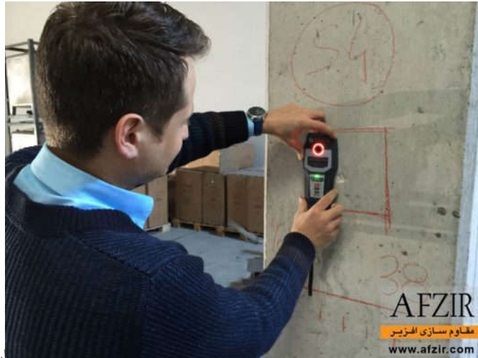
اسکن آرماتور در بتن
