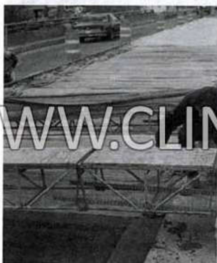
شکل ۱۱.۸ الف عمل آوری خیس با پارچه کرباسی و ورق پلاستیک روی عرشه ی پل بتنی میکروسیلیسی.
