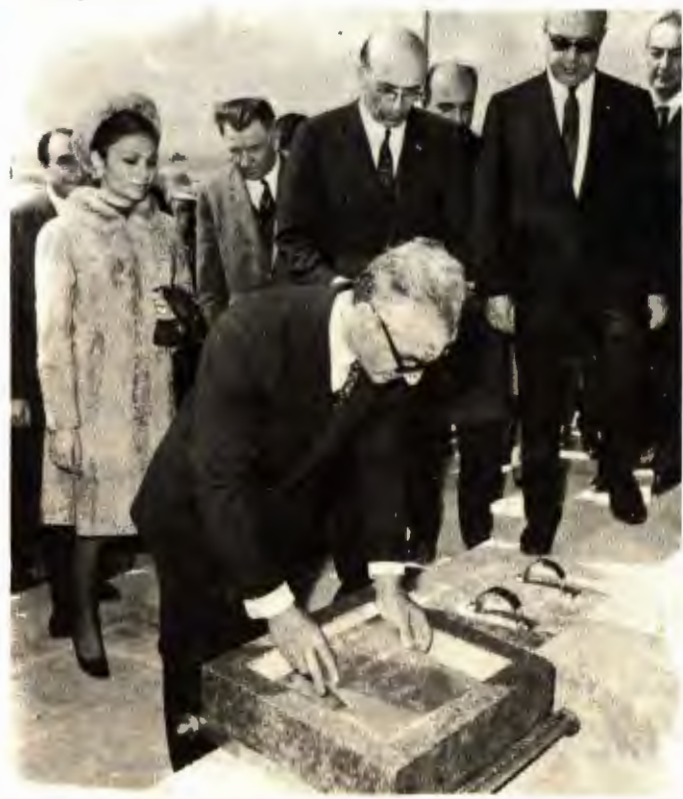
نصب لوحه بنای ذوب آهن اصفهان
