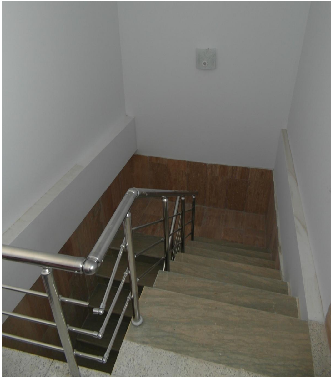
بیرون زدگی تیرهای اطراف باکس پله
